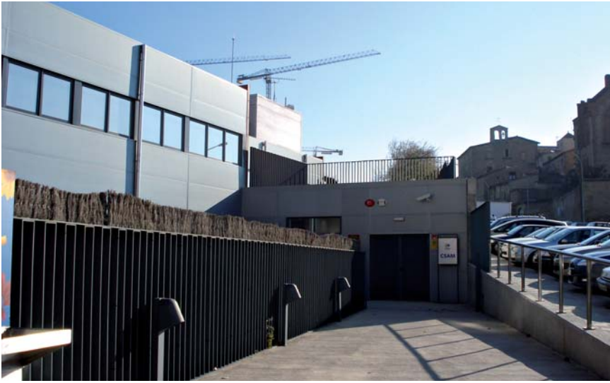
Accés a les instal·lacions al Centre de Salut Mental de la Fundació Althaia
