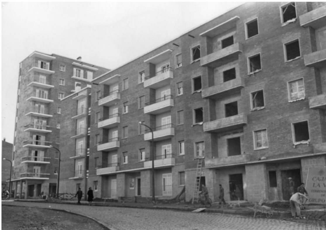
Foto: Arxiu Comarcal del Bages
