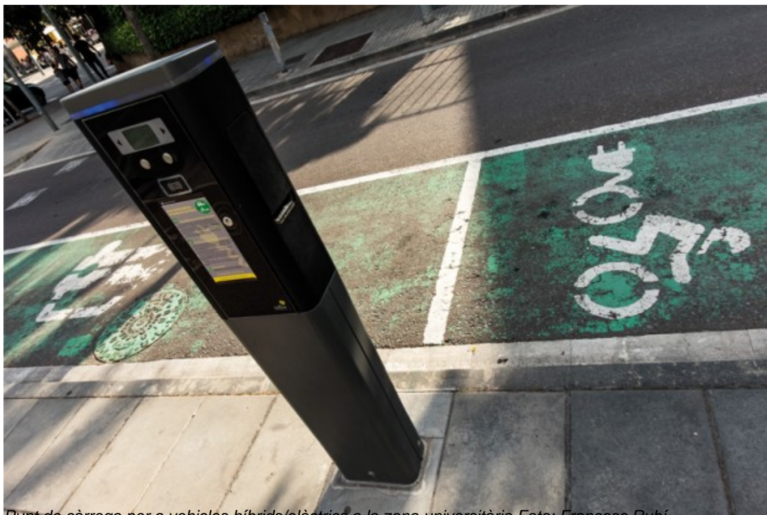
Punt de càrrega per a vehicles híbrids/elèctrics a la zona universitària Foto: Francesc Rubí
