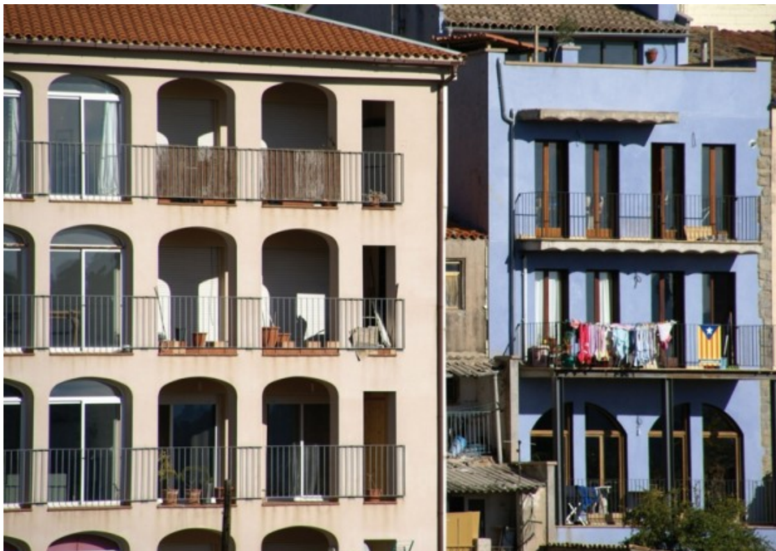
Façanes al Barri de les Escodines
